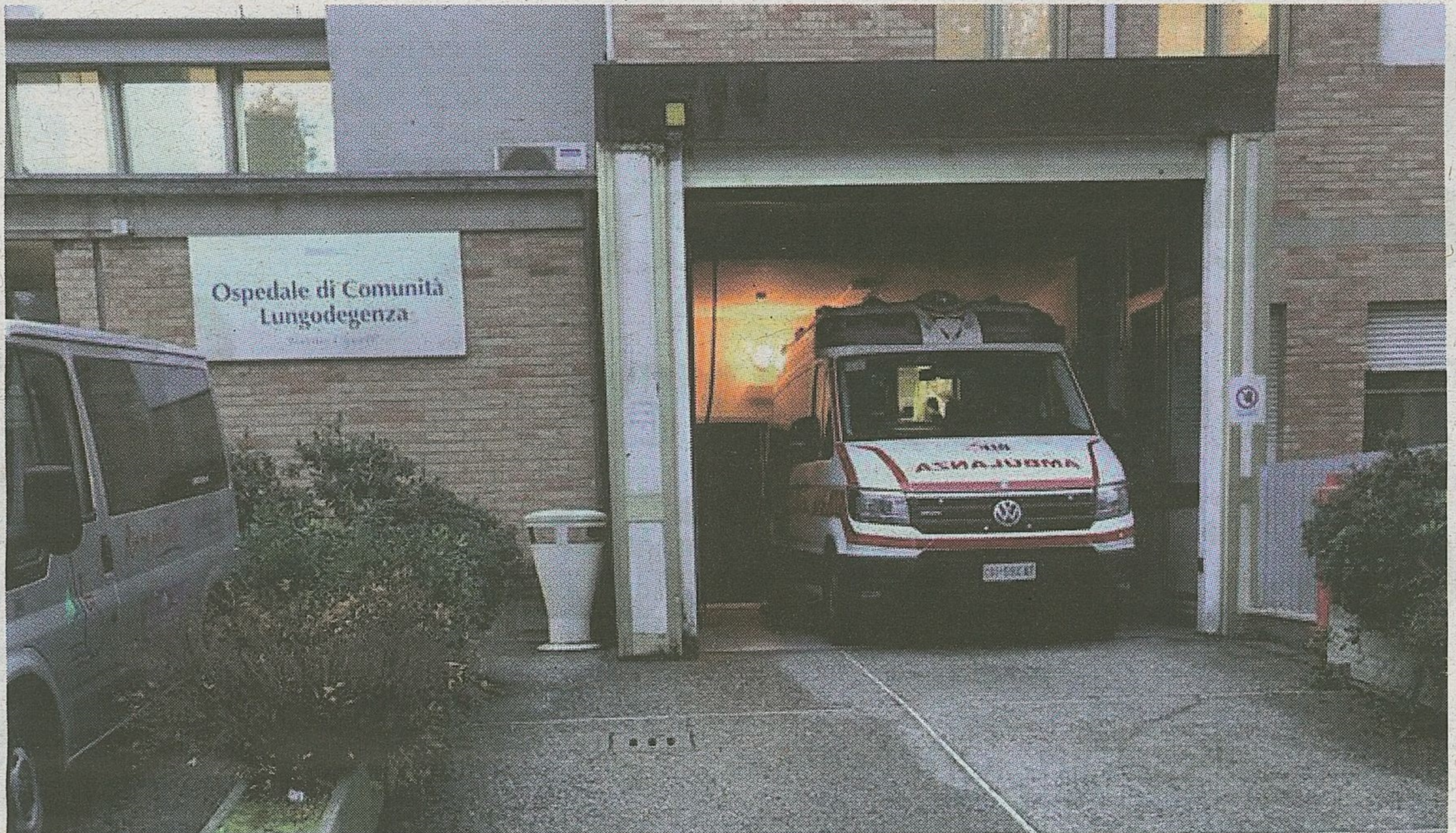
L'esterno del punto di primo intervento dell'ospedale Cappelli di Mercato Saraceno
